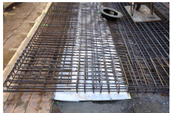
Gleitlager über der Längswand
