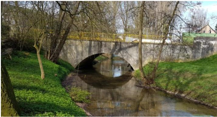
Das Haupttragwerk ist ein unbewehrter Betonbogen mit 7,50 m Stützweite bei einem Bogenstich von 2,20 m. Die Flügelwände sind Schwergewichtsmauern aus unbewehrtem Beton. Die Bestandsunterlagen sind sehr lückenhaft. Deswegen mussten die Abmessungen der Bauteile durch Kernbohrungen ermittelt werden.
