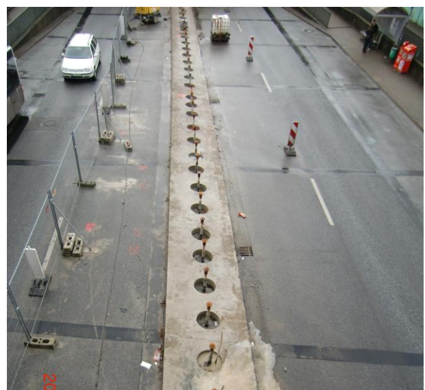
Herstellung der Gewi-Pfähle (oben) und fertige Pfahlreihe vor Herstellung des Pfahlkopfbalkens (unten)
