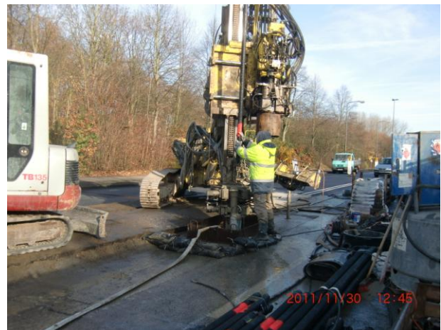
Herstellung der Gewi-Pfähle (oben) und fertige Pfahlreihe vor Herstellung des Pfahlkopfbalkens (unten)
