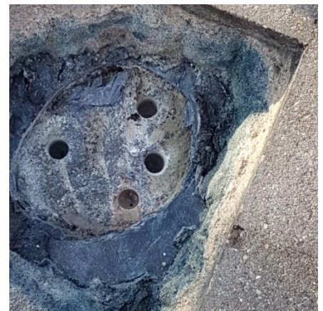
Mischprobenentnahme aus drei Bohrungen, eine Fehlbohrung
