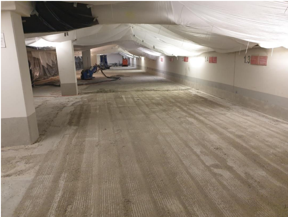
Alte OS-Beschichtung im 1. UG abtragen
